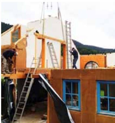
Nach 21 Jahren wird das Fertigteilhaus abgebaut. Beim Abtragen zeigte sich deutlich:
