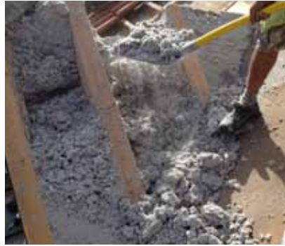
... wird nach dem Freilegen ...
