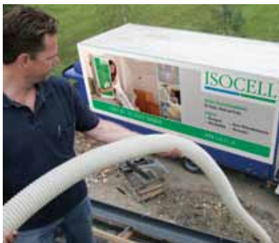
Der Schlauch wird an den Einsatzort gebracht.
