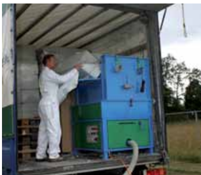
Eine starke Maschine im LKW befördert das Material durch den Schlauch bis zu den vorgefertigten Hohlräumen.
