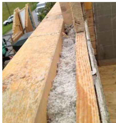
Die in den Außen- und Zwischenwänden zur Dämmung eingebrachte Zellulose wies nach 21 Jahren
