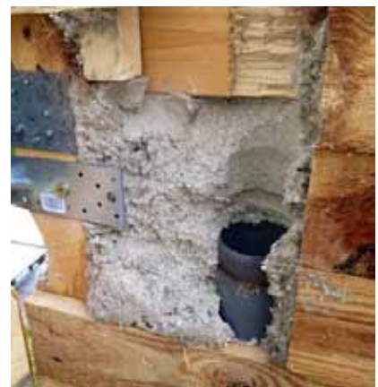
keinerlei Spuren von Setzung oder Verformung auf.
