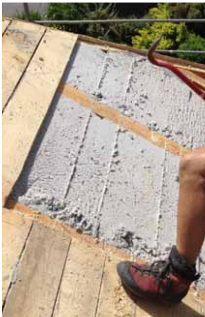
Nach 17 Jahre geöffneter Dachstuhl; Die ISOCELL Zellulose wirkt wie frisch eingeblasen.
